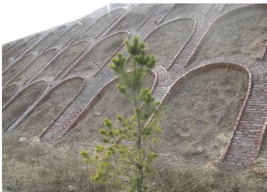
砖砌式拱形骨架护坡
