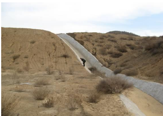
K42+000 弃土场排水沟
