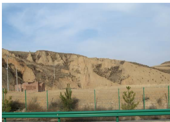
K44+200 处施工场地复耕
