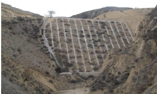
K45+400 弃土场挡墙、排水沟及坡面拱形骨架
