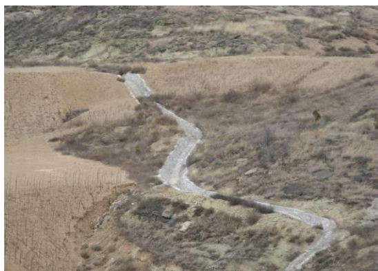
K39+045 弃土场弃土面复耕及排水沟
