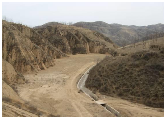
K45+600 弃土场排水沟
