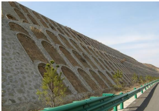
路基拱形骨架护坡
