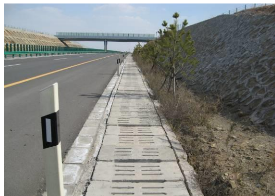
路基护坡及排水沟
