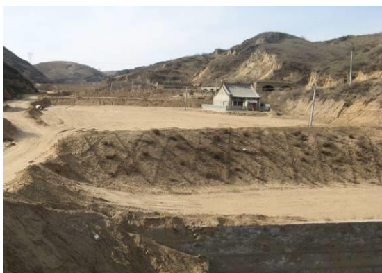
K 34+100 弃土场表面复耕及坡脚挡墙
