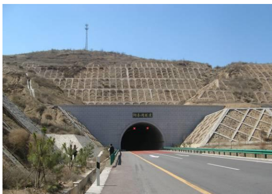
隧道出口两侧及洞脸防护
