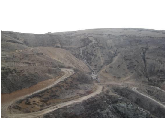
K 45+200 弃土场弃土面绿化及临时道路
