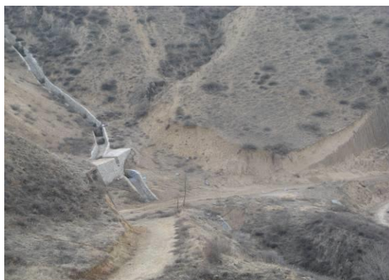
K45+200 弃土场排水沟
