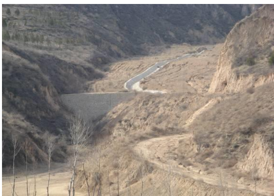
K36+507 弃土场挡墙及排水沟
