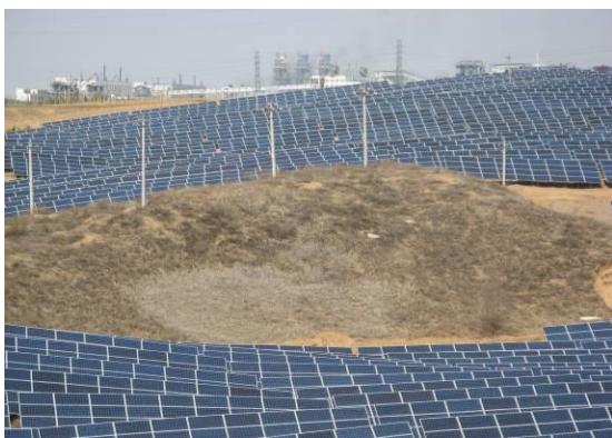
K0+600 弃土场坡面光伏版覆盖
