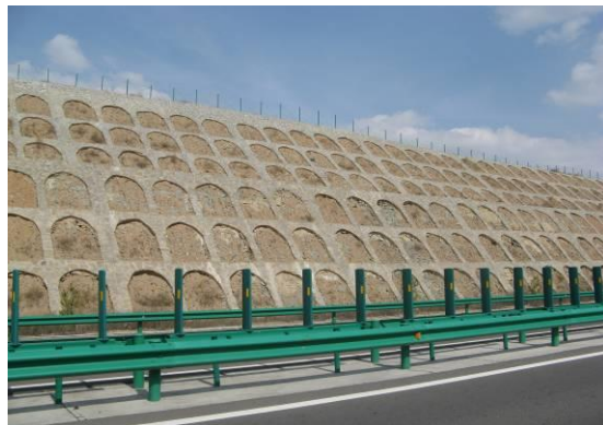
路基窗孔式护面墙（砌石）
